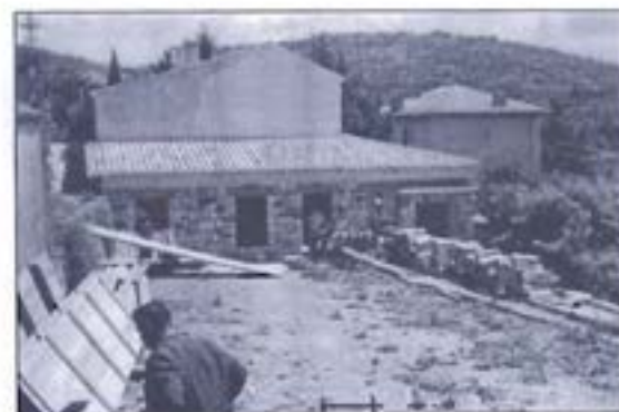
Gradnja počitniškega doma v Portorožu
